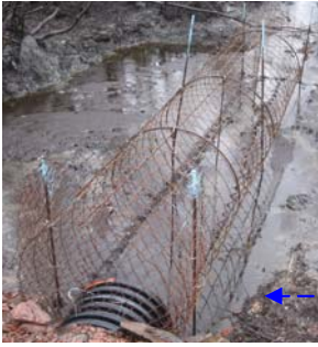
Figure 2. Treillis de 36 po installé sur un ponceau de 18 po
