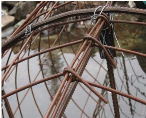
Figure 7. Fourchettes d'armature fixée au dispositif
