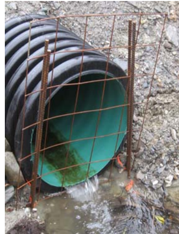
Figure 8. Grille en aval
