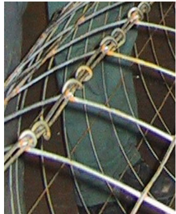
Figure 4. Principe de jointure d'une section de treillis
