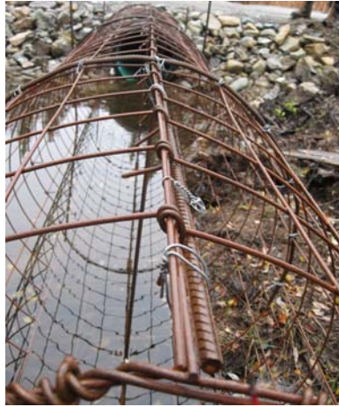
Figure 5. Tige d'armature horizontale fixée au dispositif
